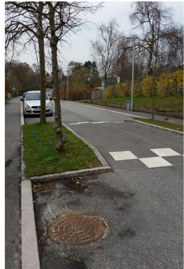
Eksempel på forsætning som ikke er udført hensigtsmæssigt i forhold til driften, idet der skal håndfejes i hjørnet.
