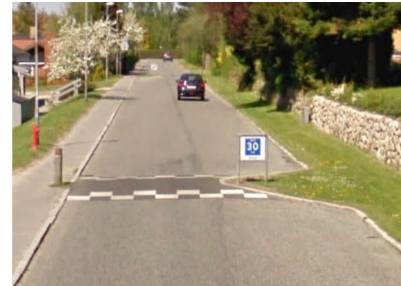
Søageren - Indsnævring med bump
